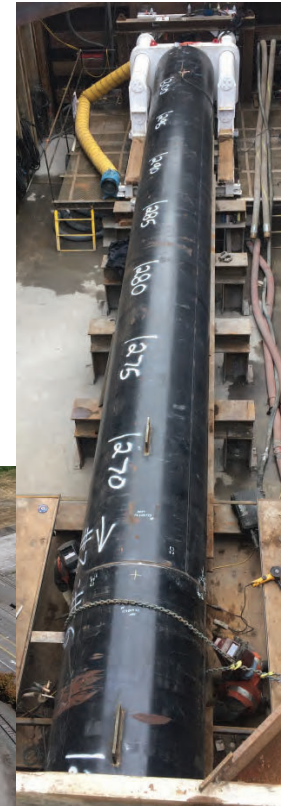
Installation of LNG pipeline casings
