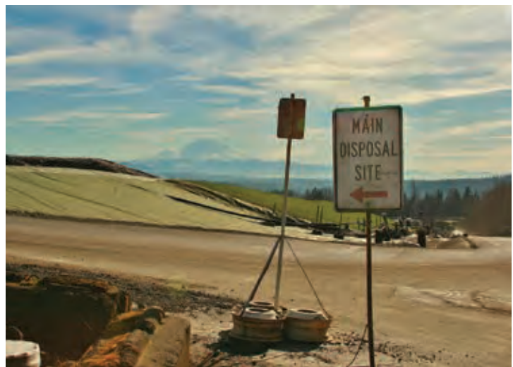
Cedar Hills Regional Landfill
